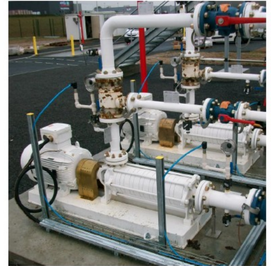
Pompe pour le chargement des camions citernes
