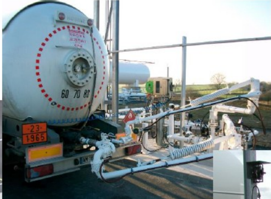
Chargement et Déchargement des camions citernes
